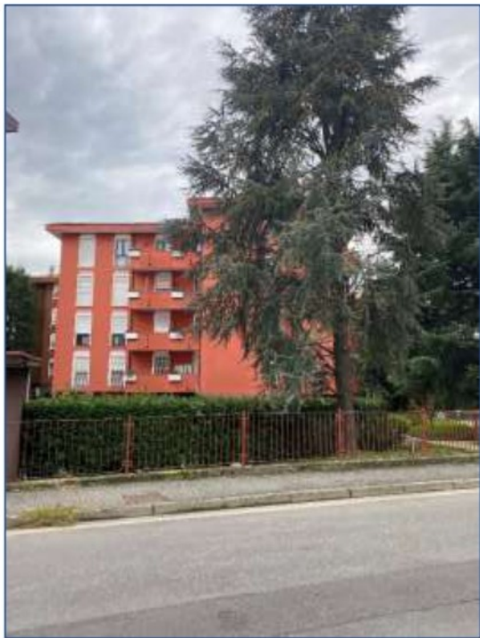
Foto 1 - immobile di via XXV Aprile n. 24
